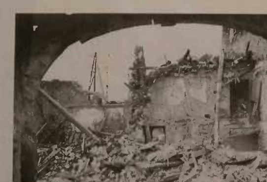
Schweitzerecke (Op der Spatz) «Schweitzereck (op der Spatz)»
