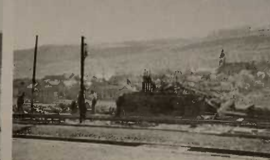
Wasserturm am Bahnhof Réservoir d'eau de la gare
