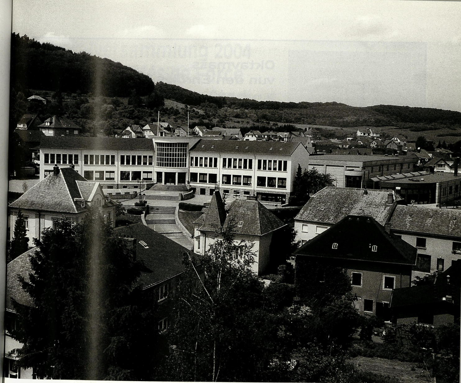
Primärschule, Steinsel, bâtiment „Sepp Hansen“
