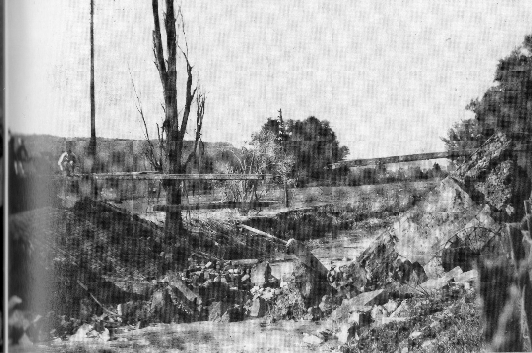
Nach der Sprengung der Alzettebrücke wurde zunächst einmal ein schmaler Fußgängersteg über den Fluß angebracht. Etwas später errichteten dort Pioniereinheiten der US-Armee eine Notbrücke aus Holz, die auch von schweren Armeefahrzeugen benutzt werden konnte. Damit waren die Ortsteile Walferdingen und Helmsingen einerseits und Bereldingen andererseits wiederum miteinander verbunden.
